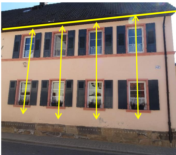
Achsis übereinanderstehende Fenster prägen die vertikale Fassadengliederung von traufständigen Gebäuden.
