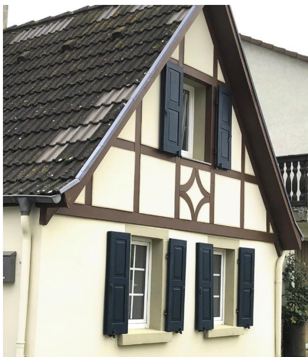
Die sichtbaren Fassadenbauteile sind hier aus traditionellen, ortsüblichen Materialien wie Holz, Naturstein (Sandstein) und glattem Putz hergestellt. Das Fachwerk wurde erhalten.
