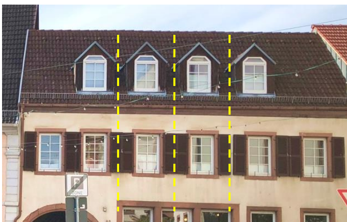
Positivbeispiele: Symmetrische Anordnung der nachträglich aufgesetzten Gauben, sowie Anpassung ihrer Breite an Fassadenfenster- und gliederung.
