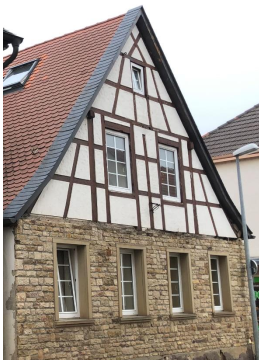
Die sichtbaren Fassadenbauteile sind hier aus traditionellen, ortsüblichen Materialien wie Holz, Naturstein (Sandstein) und glattem Putz hergestellt. Das Fachwerk wurde erhalten.
