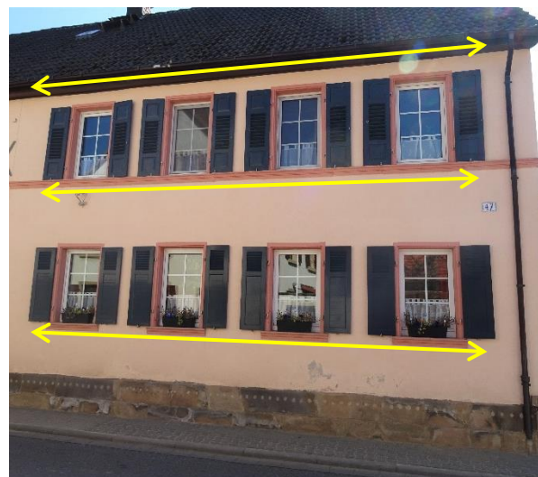
Die Fenster sind gleichgroß und liegen horizontal, in regelmäßigen Abständen, bandartig auf einer Linie.
